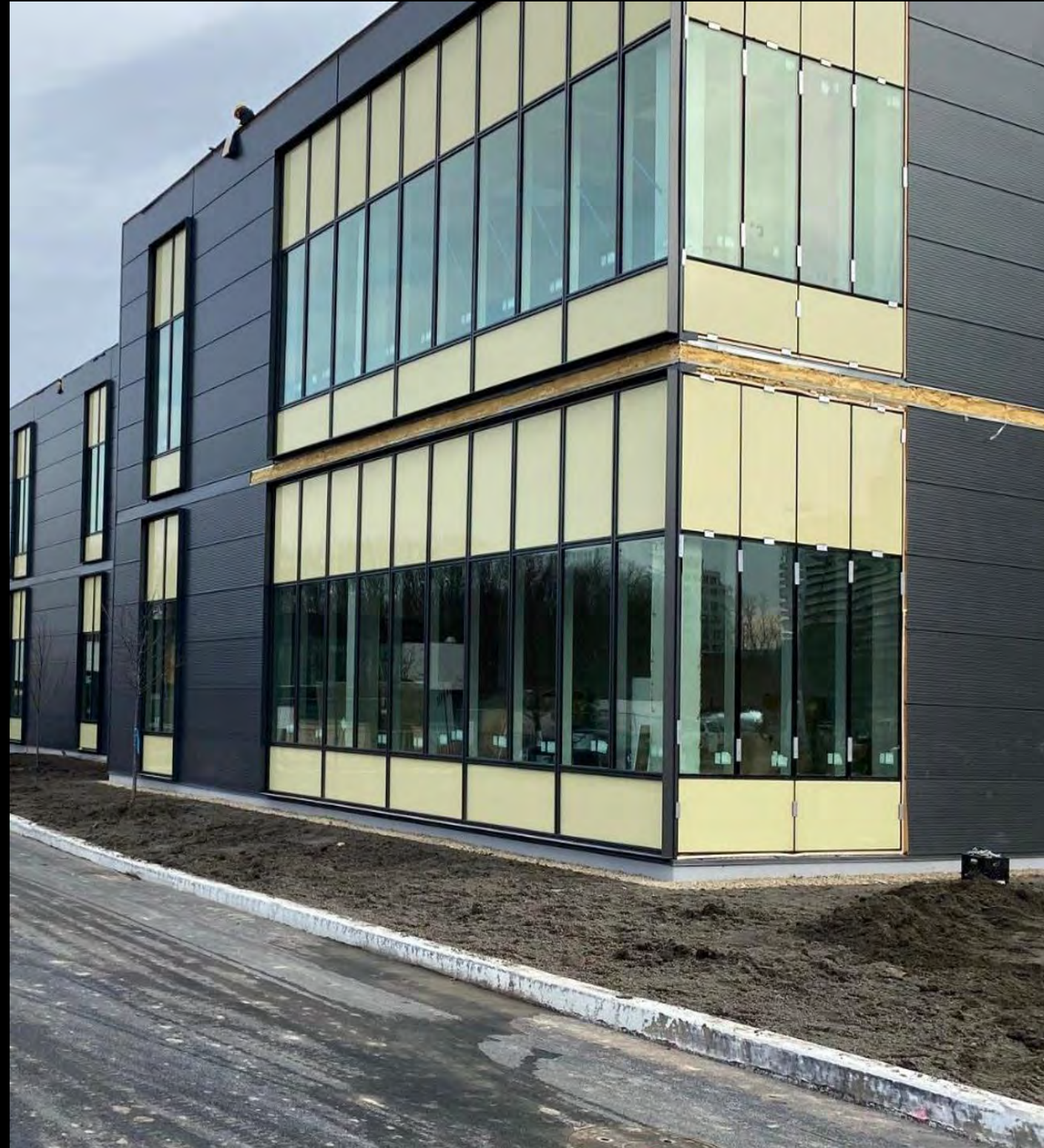
Complexe Modulaire Hôpital Maisonneuve-Rosemont
