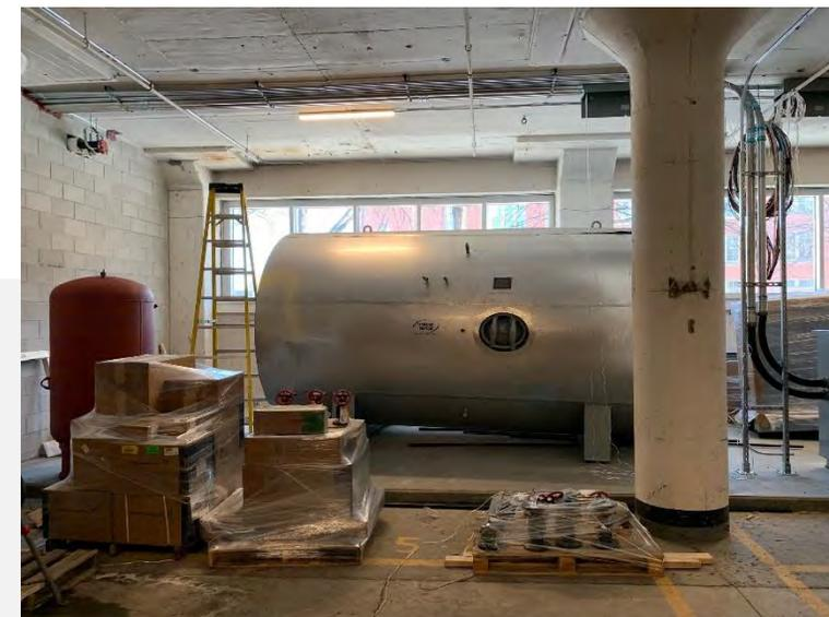
Banque de chaleur - Réservoir d'est chaude sur le réseau de chauffage radiant hydronique
