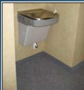
Il est préférable d'encastrer les fontaines dans une alcôve : cela évite ainsi de créer des saillies pouvant nuire aux personnes ayant une incapacité visuelle. Cependant, la base de l'appareil doit être située à au plus 680 mm pour être détectée par une personne utilisant une canne blanche.
